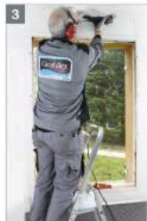
3 Découpe de l'isolation intérieure (doublage polystyrène et Placoplatre)
