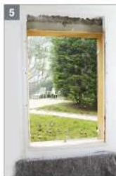
5 Support prêt à l'isolation
