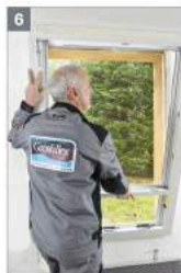
6 Pose de la nouvelle menuiserie équipée du volet, celui-ci se positionne derrière le linteau et ainsi le clair de jour est préservé
