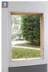
2 Dépose des ouvrants et de la traverse
