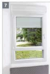
7 Menuiseries posées finitions effectuées
