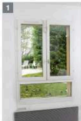
1 Vue intérieure avant travaux (fenêtre bois)
