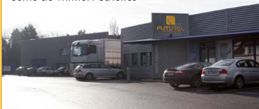
Usine de Thimert Gatelles
